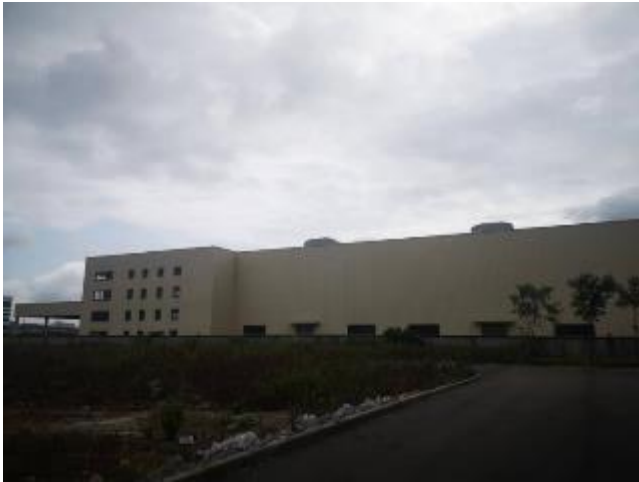
项目东侧 空置厂房
